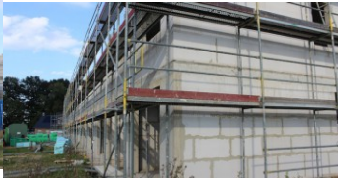
Richtfest im Erlenhof: 33 Reihenhäuser entstehen im Pomonaring. Foto:ahrensburg24.de
