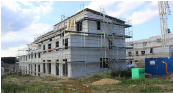
Richtfest im Erlenhof: 33 Reihenhäuser entstehen im Pomonaring. Foto:ahrensburg24.de
