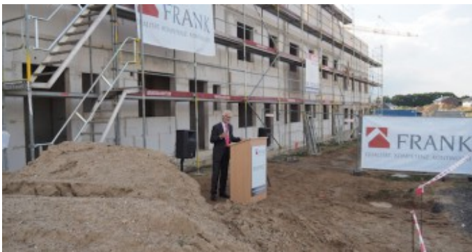
Richtfest im Erlenhof: 33 Reihenhäuser entstehen im Pomonaring. Bürgermeister Michael Sarach spricht zu den Gästen des Richtfestes. Foto:Clemens Thoma/Frank Gruppe
