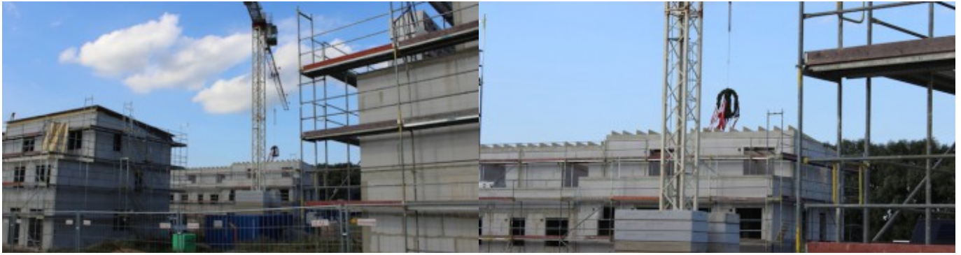
Richtfest im Erlenhof: 33 Reihenhäuser entstehen im Pomonaring. Foto:ahrensburg24.de
