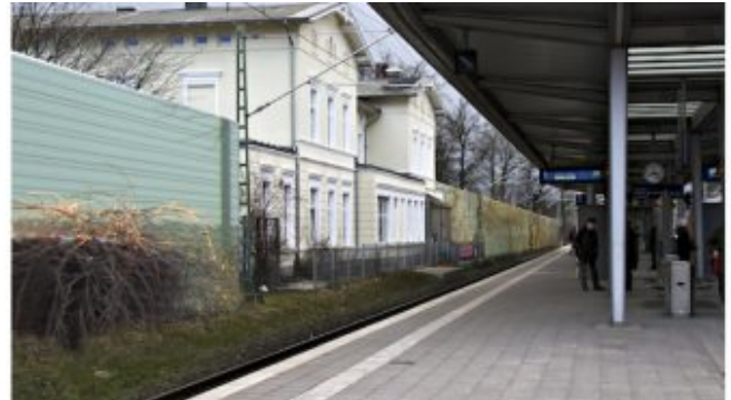
Neue Lärmschutzwände entlang der zukünftig ausgebauten Bahnstrecke auf Ahrensburger Stadtgebiet: Die Stadtverwaltung hat digitale Vorschauen gefertigt. Im Bild der Bereich des Bahnhofes. Grafik/Montage:Stadtverwaltung Ahrensburg
