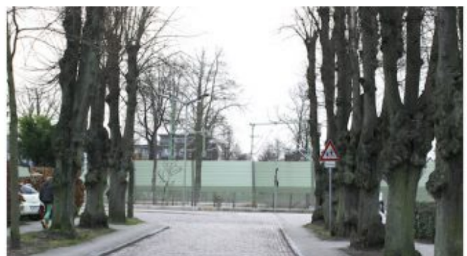
Neue Lärmschutzwände entlang der zukünftig
