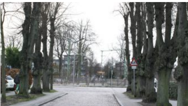
Neue Lärmschutzwände entlang der zukünftig
